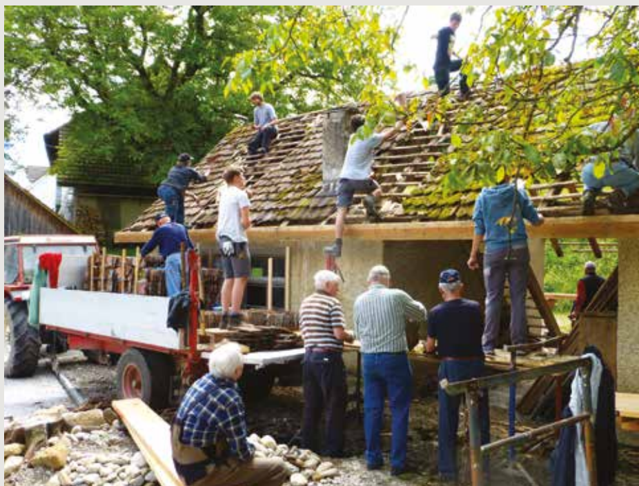
S'inspirer de solutions élaborées pour répondre aux besoins du troisième âge – à l'exemple de la résidence Gemeinschaftshof à Niederweningen ZH, conçue pour permettre aux personnes âgées de la région de loger dans le centre du village et d'y mener une vie active, tout en offrant un lieu de rencontre pour tous, résidents et habitants du village (transformation de l'ancienne buanderie en magasin) Photo: Urs Bürchler
